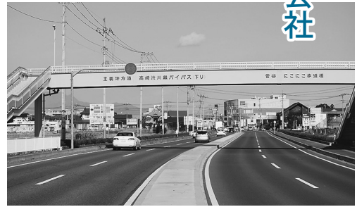
▲施工実績：歩道橋
